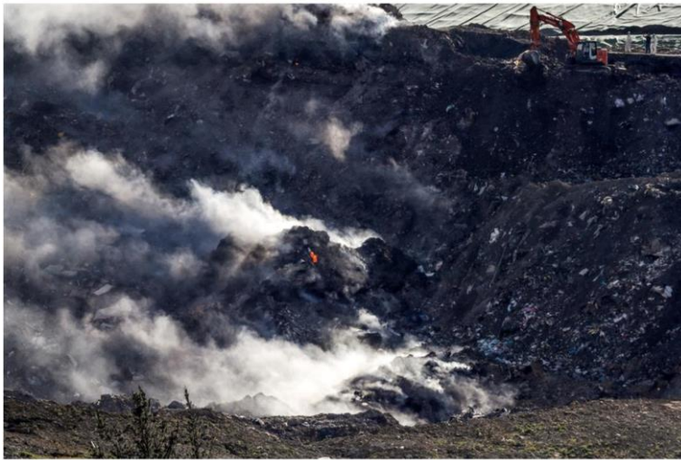
Trabajos de extinción de los incendios del Vertedero de Zaldibar. EFE
